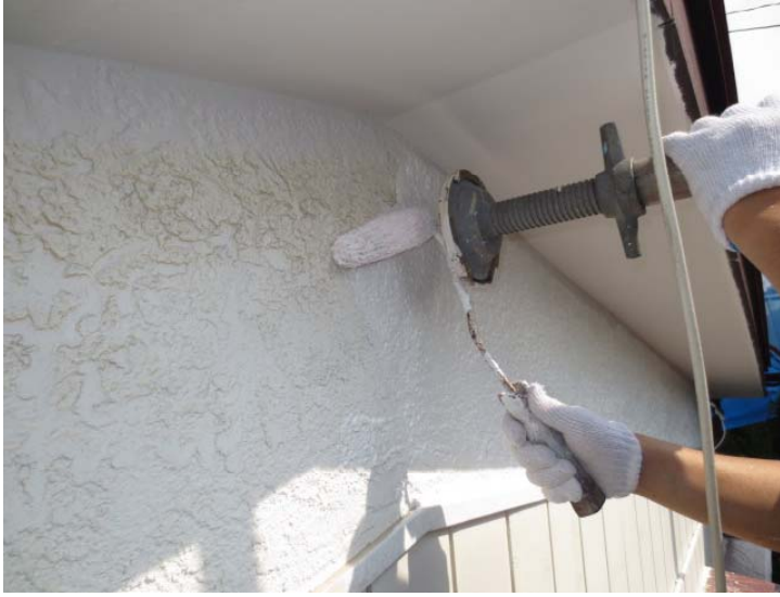
小壁部分下塗り。
