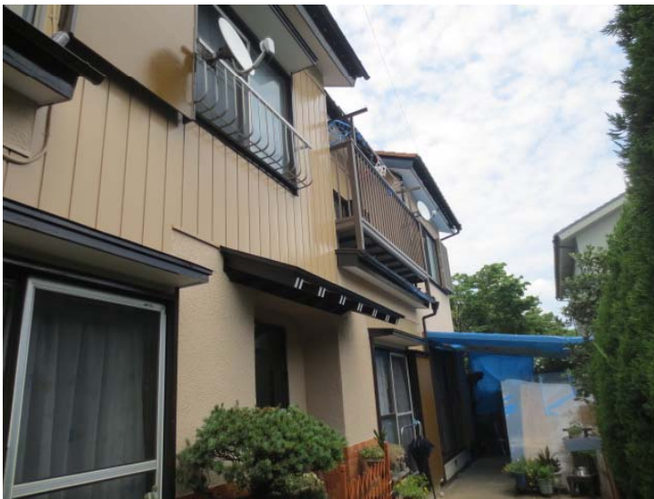
完成後全景写真。
