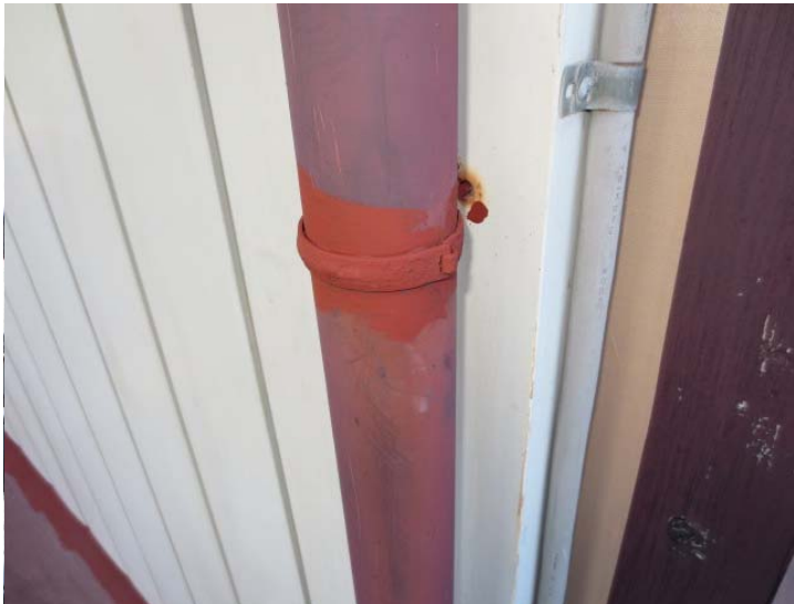
雨樋固定金具エポキシ錆止め塗装。
