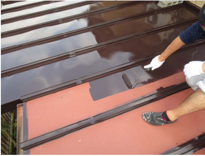
瓦棒屋根仕上げ塗り。
