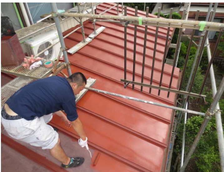
瓦棒屋根エポキシ錆止め塗装。
