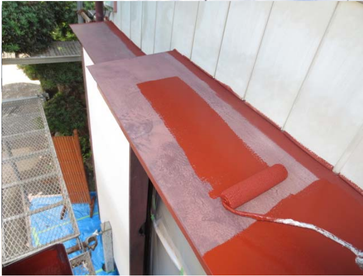
鋼板部分エポキシ錆止め塗装。
