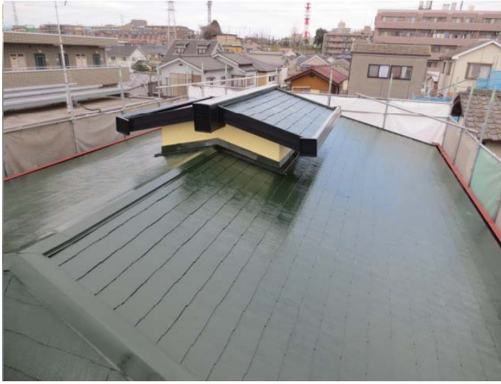
屋根遮熱塗装完了後
