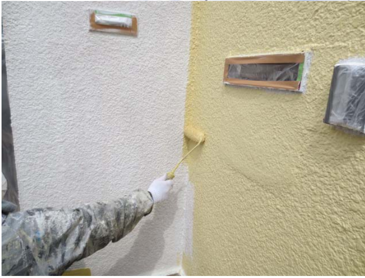
ブロック塀中塗り
