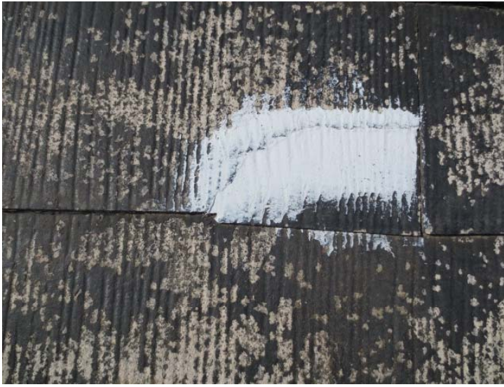
ひび割れ部分シール補修
