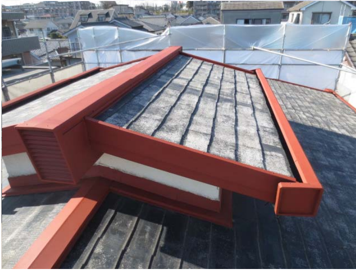
鉄部エポキシ錆止め塗装
