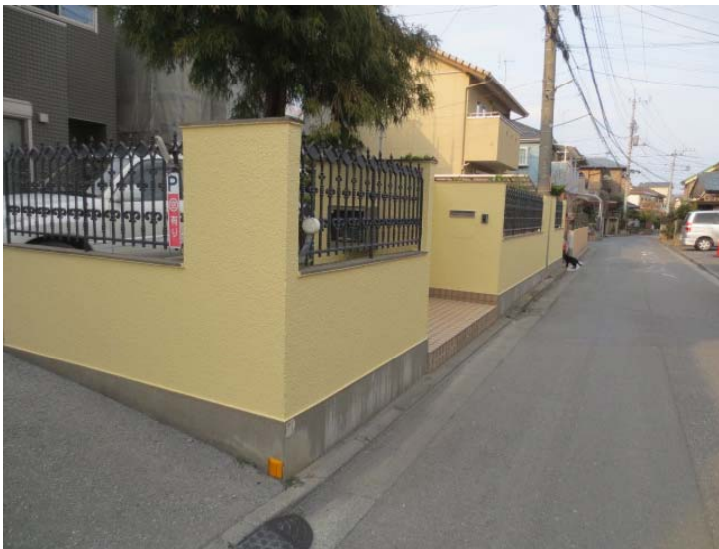
ブロック塀完了後
