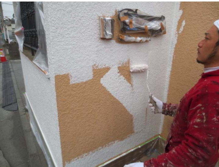
ブロック塀微弾性フィラー下塗り
