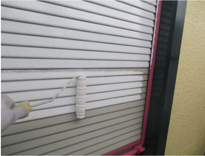
エポキシ錆止め塗装
